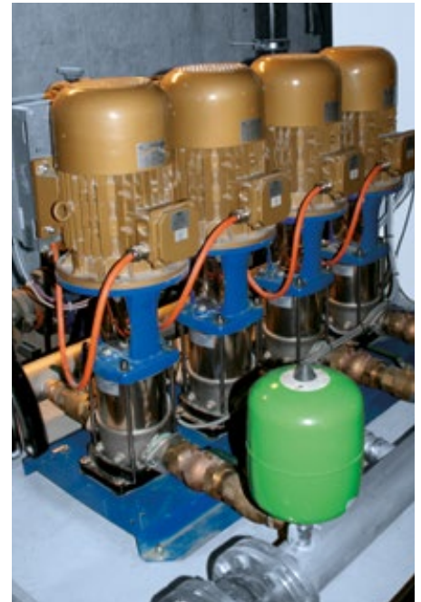
Movitec PumpDrive avec le moteur SuPremE®-IE4*- de KSB
