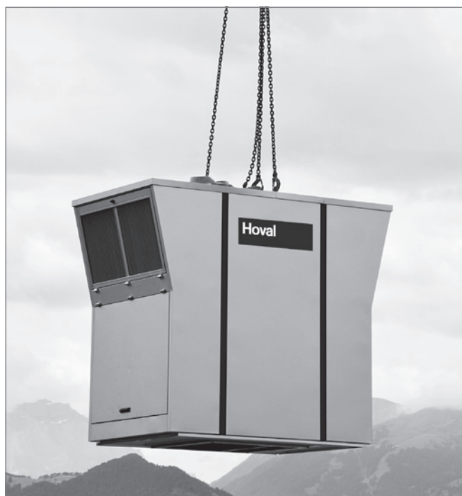
Fig. F6: Pose de l'appareil de toiture au moyen des anneaux de levage vissés
