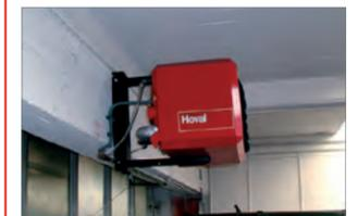
Les TopVent® GV sont destinés à être installés sous la toiture ou sur un mur.
